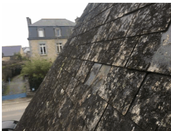
S37 - 1 (S37) - Ancien cinéma - Toiture - Vol 21 (Toiture)
