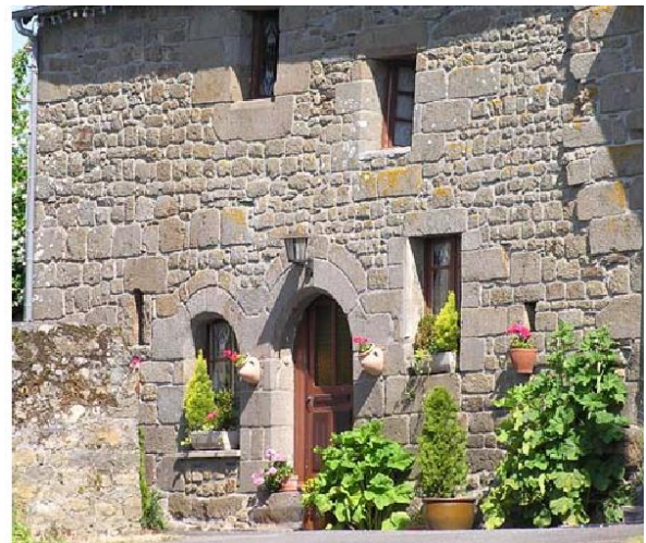
Maçonnerie de moellons de dimensions très hiérarchisée selon leur fonction
